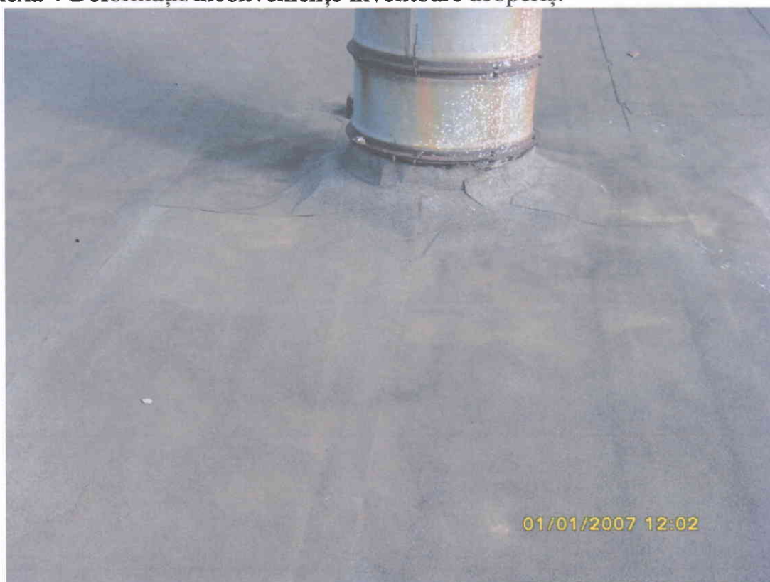
d: Anexa 4: Deformații/inconveniențe învelitoare acoperiș.
