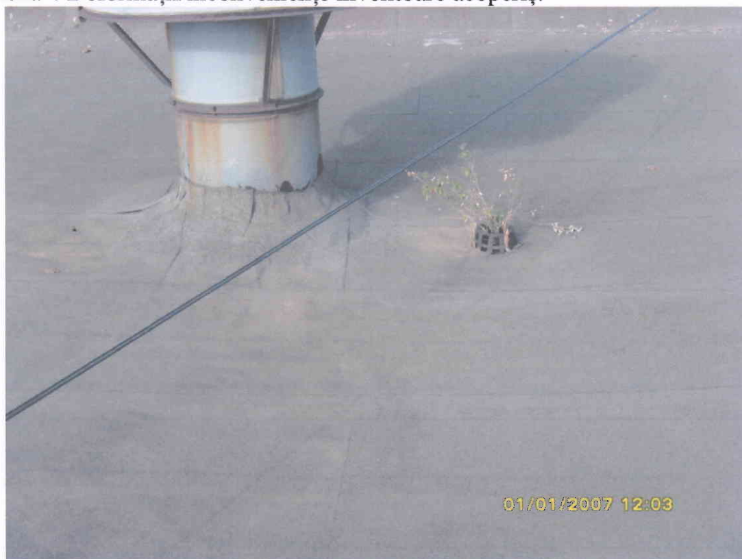
f: Anexa 4: Deformații/inconveniențe învelitoare acoperiș.
